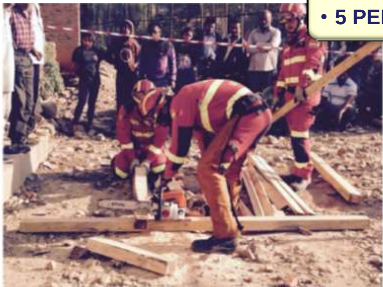
Tareas de preparación de apuntalamiento de infraestructuras en CHAPAGAUN.
